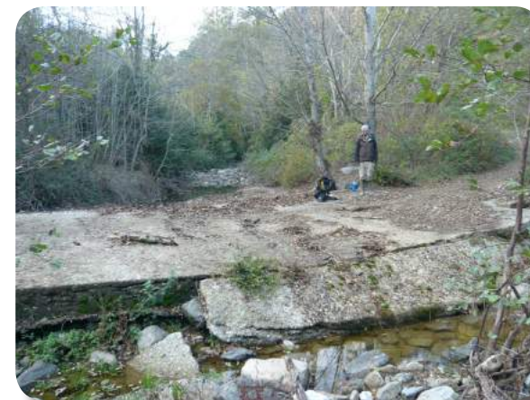
Photo : Seuil abimé (M2 EGPEM)
