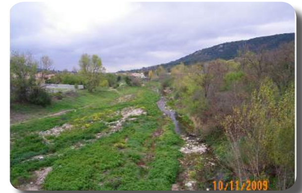
Photo : Elargissement du Mialan au niveau du pont au hameau de Le Queyron (M2 EGPEM)
