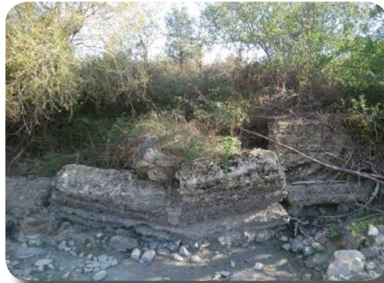
Photo : Epi détruit au niveau du hameau La Pra (M2 EGPEM)
