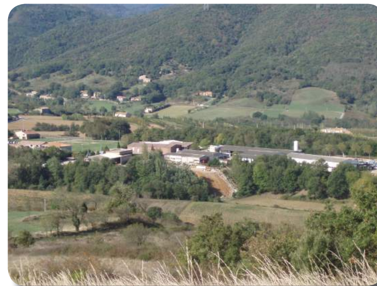
Photo : Zone artisanale de Toulaud vue des hauteurs à l'est de la commune (M2 EGEPM)
