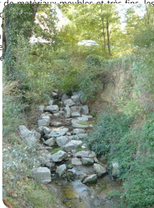
Photo : Enrochement déplacé au hameau Les Fonts (M2 EGEPM)
