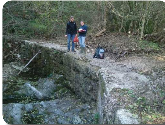
Photo : Barrages abandonnés à proximité de Saint Loup (M2 EGEPM)
