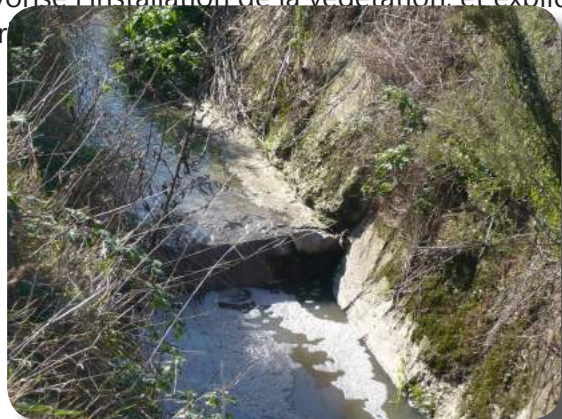
Photo : Chenal bétonné au niveau du hameau les Riailles (M2 EGEPM)
