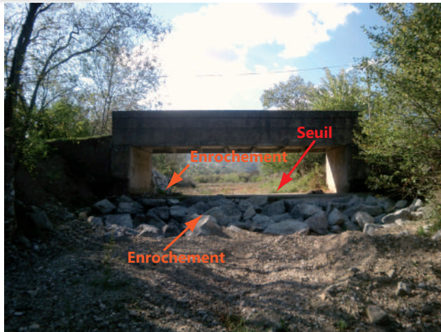
Photo : Chenal bétonné au niveau du hameau les Riailles (M2 EGPEM)
