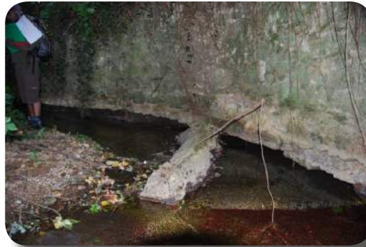
Photo : Sapement du pont au niveau du hameau de Combe (confluence de l'Ozon avec l'Embroye) (M2 EGEPM)
