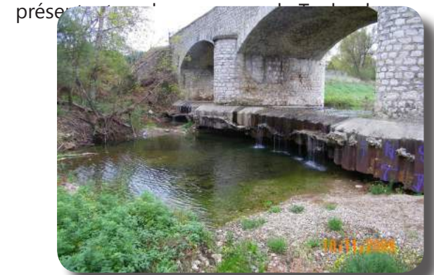
Photo : Déchaussement du pont au lieu dit Le Queyron (M2 EGPEM)
